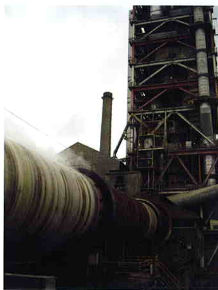
セメント工場 (手前:キルン)
