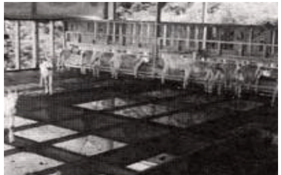
写真7-2 新築の山羊舎（床は金網張り）
