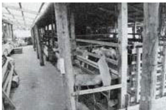
写真 13 - 1 廃材の利用で改築した山羊舎内
